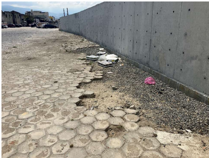
Foto 1 : reparo nos bloquetes.
